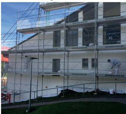
er Abrieb aufgezo-gen. Die oberste Westfassade, welche komplett ohne Fenster ist, wurde mit einer 16 cm dicken Fassadendämmung versehen und ebenfalls neu verputzt. Die ganze Fassade wurde danach neu gestrichen.
