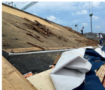
welcher 1984 erstellt wurde, konnte eine einiger-massen vernünftige Dämmung aufweisen. Die Dachdecker nahmen bereits einige alte Ziegel weg und legten eine orange Folie über die Öffnungen. Später entfernten sie alle Dachziegel und erneuerten diese am Schluss auch. Sie entfernten die alten Dachlatten und setzten neue ein.
